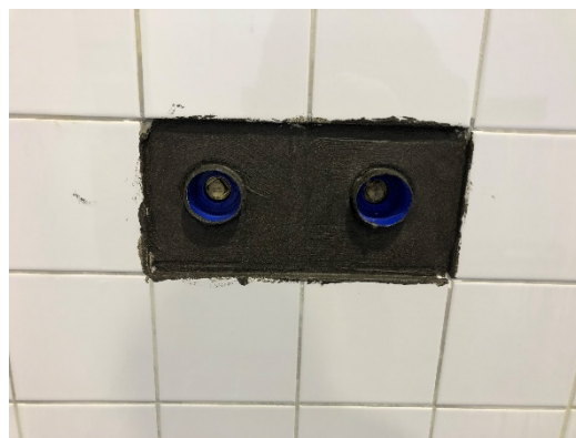
Bild 19. Exempel på delreparation av tätskikt kring väggomföring
