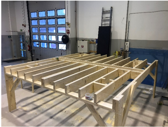
Bild 4. Bild från byggandet av mock-upen
