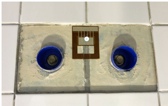
Bild 24. Placering av fuktsensor efter delreparation på vägg i provutrymme 2 (Badrum 2)
