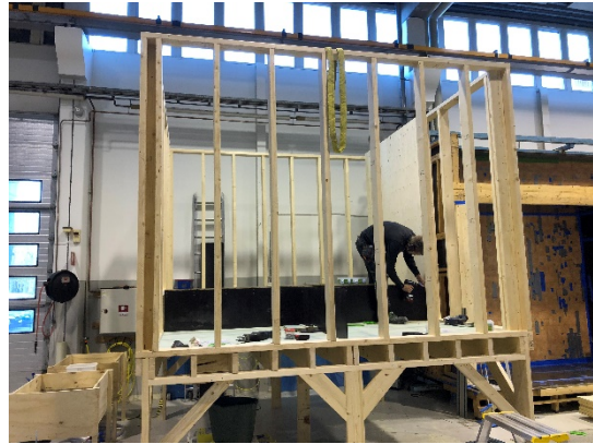
Bild 5. Bild från byggandet av mock-upen
