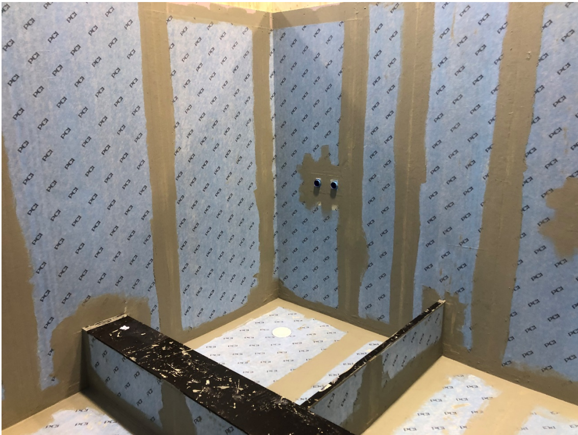
Bild 6. Mock-upens insida har beklänts och belagts med tätskikt av folietyp.
