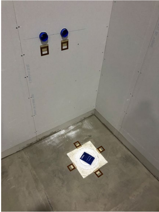
Bild 7. Invisenses självhäftande fuktsensorer monterade vid golvbrunn och väggomföring
