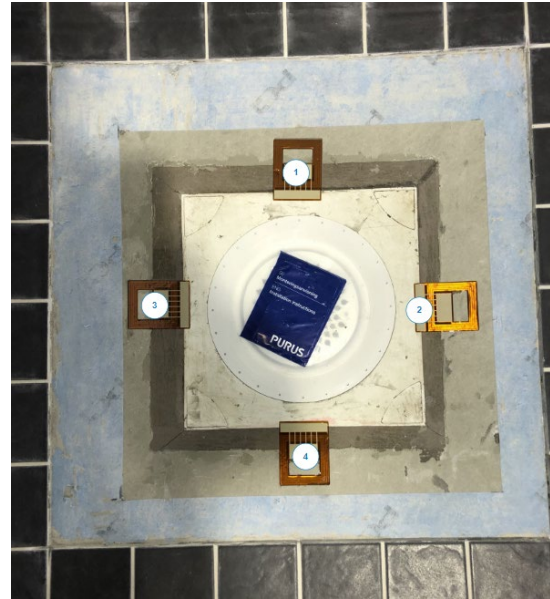
Bild 23. Placering av fuktsensorer vid golvbrunn i provutrymme 1 (Badrum 1)
