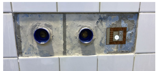
Bild 27. Placering av fuktsensor efter delreparation på vägg i provutrymme 4 ((Badrum 4)
