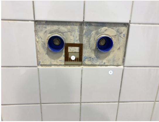
Bild 22. Placering av fuktsensor efter delreparation på vägg i provutrymme 1 (Badrum 1)
