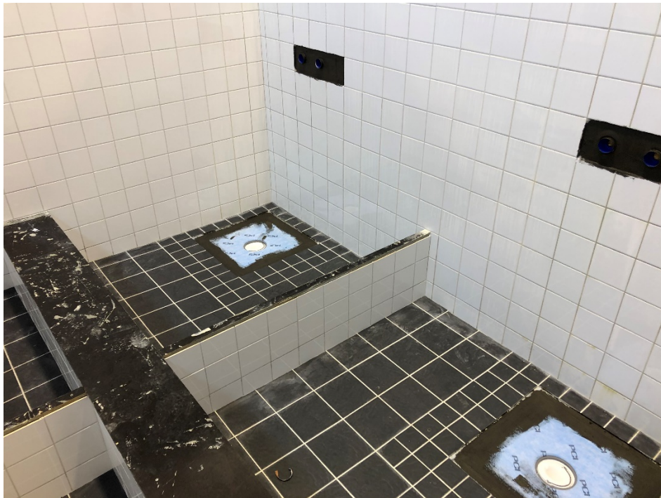
Bild 17. Exempel på delreparation av tätskikt
